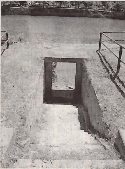
選奨土木遺産に選ばれた「京橋川雁木群」の雁木の一つ。上り口の天井に石が渡してある (広島市中区橋本町)
