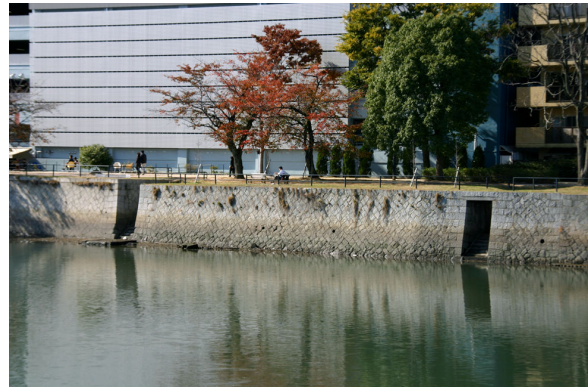
京橋川の護岸と雁木。精度の高い切込剥ぎは当時の石工の技術をうかがわせる
