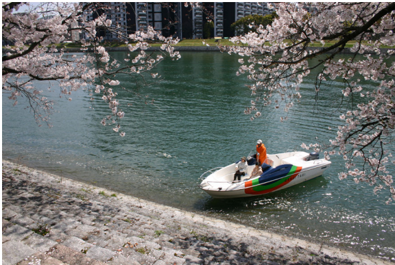
河川改修工事後の楠木大雁木（本川）と雁木タクシー
